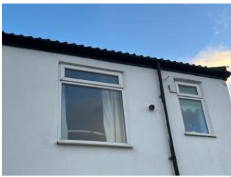
Pic 31: Timber fascias
