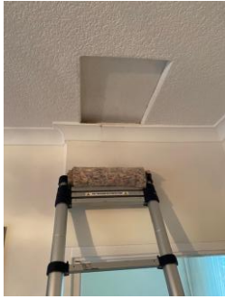
Pic 35: Original loft hatch
